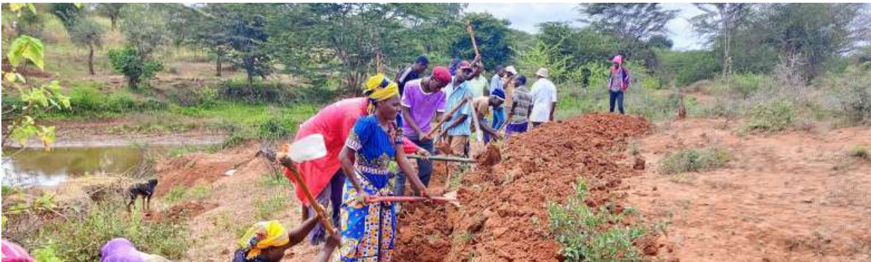
Oeverbeschermingszone wordt afgebakend
